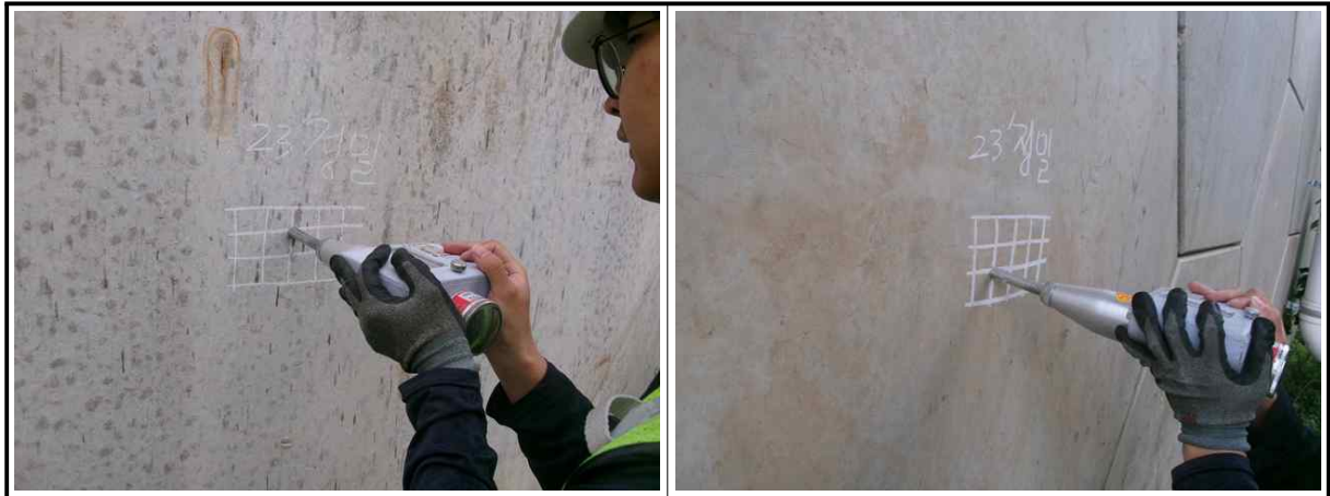
【그림 2.3.6】 슈미트해머를 이용한 반발경도시험 전경
